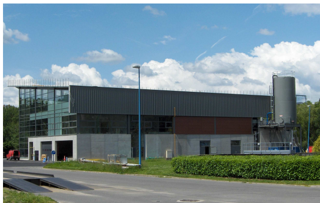
STEP de Limoges : bâtiment des filtres-presses
