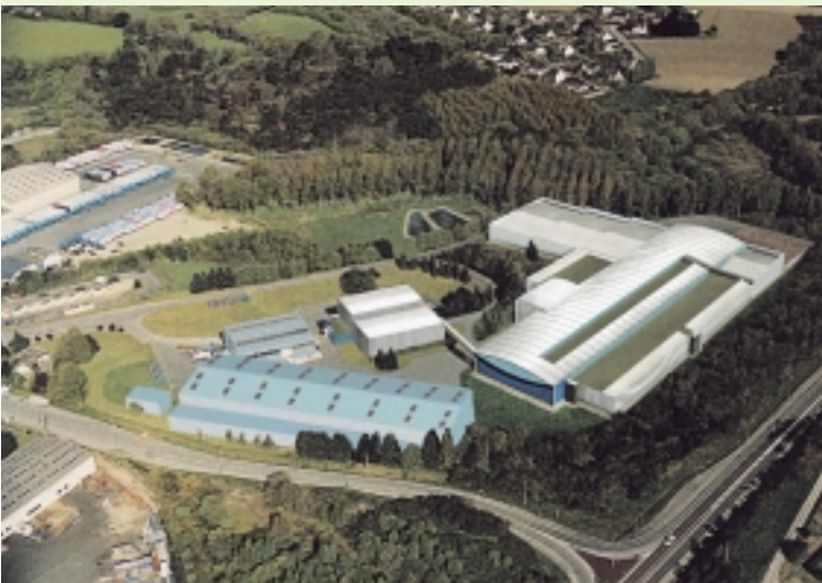
Unité de traitement des ordures ménagères de l'agglomération du pays de Lorient
