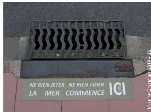
Grille pluviale avec un message de sensibilisation aux déchets plastiques
